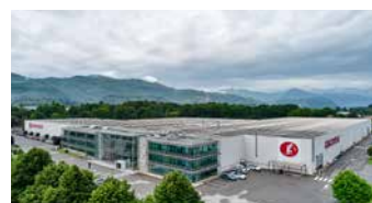
Giacomini S.p.A. Stabilimento materie plastiche San Maurizio d'Opaglio (NO) (G2)
